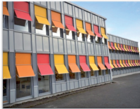
Figur 30: Ulike løsninger med solskjermingsduk, Screen på Rud skole (t.v.) og Markisoletter på Sætre skole (t.h.). Foto: solskjermingsgruppen
