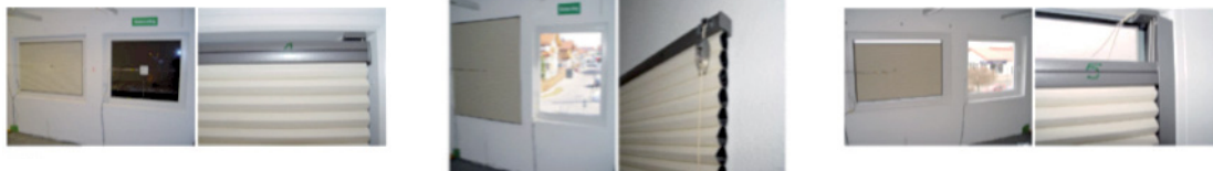
Figur 21: Ulike innfestinger av solskjerming gir ulik forbedring av varmemotstand (Heusler et. Al 2011).
