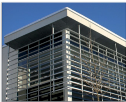
Figur 28: Faste horisontale lameller, Lunderkroken Billingstad, vertikale lameller, Teknisk museum i Oslo.
